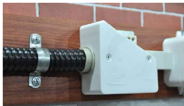
Рис. 3. Крепежные комплекты ОКЛ с использованием саморезов, дюбелей и скобы СМО и с использованием винтовой заклепки и хомута FR ПР.
