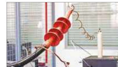
Высоковольтные испытания кабельных муфт
