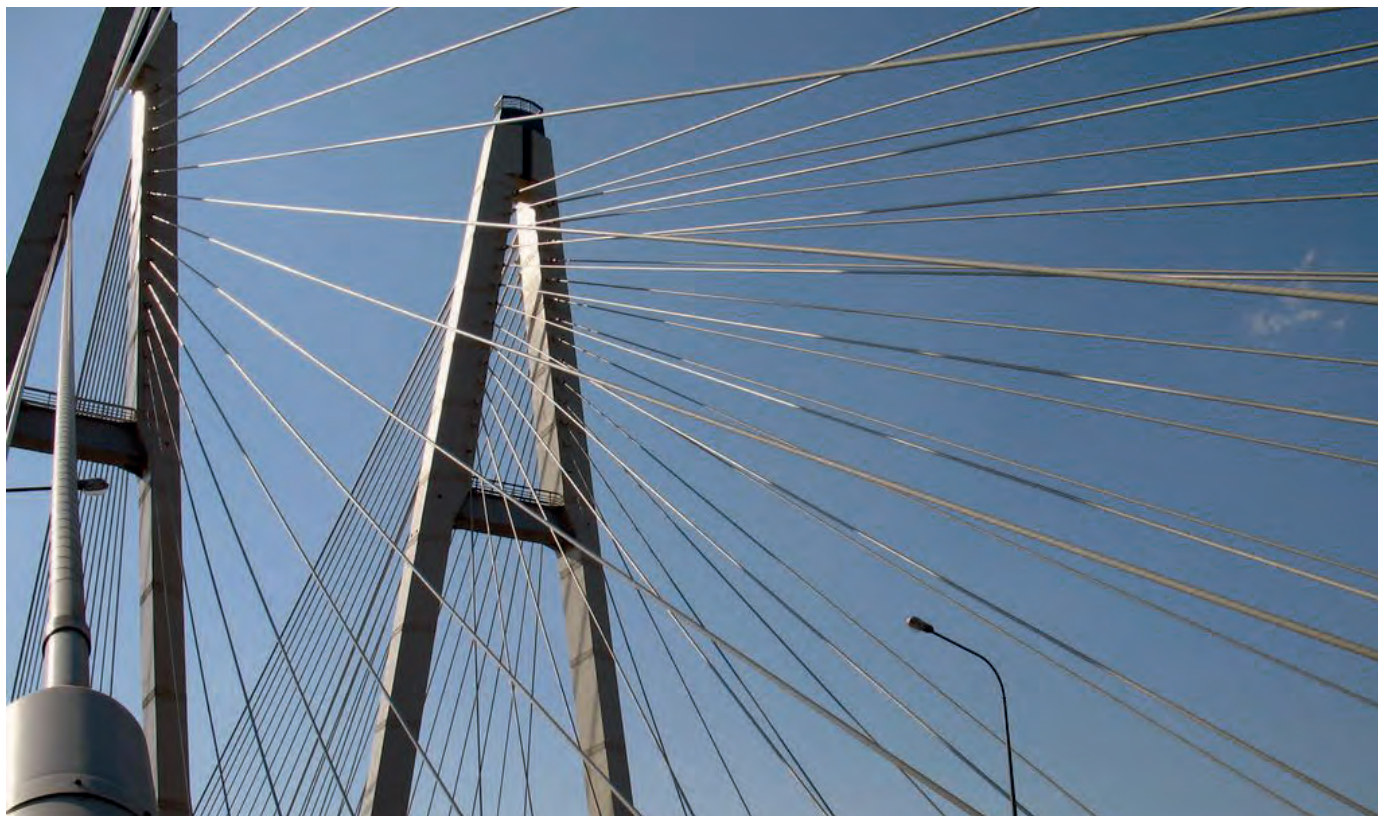
г. Санкт-Петербург, Большой Обуховский мост
