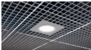
Установка светильника с переходником 300x300
