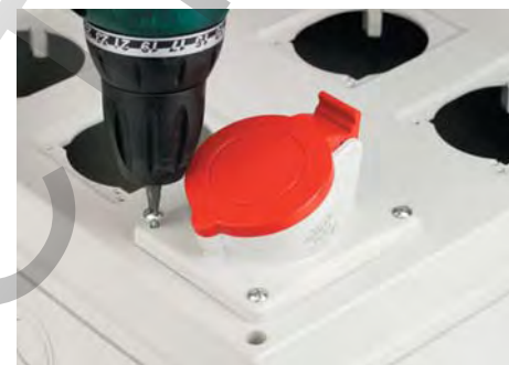
Монтаж розетки на 32 А
