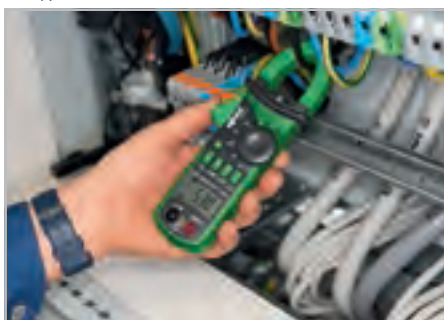
Измерения тока в распределительном шкафу
