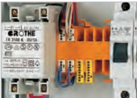
Применение в системе дверного звонка - монтаж на DIN-рейку 35 мм
