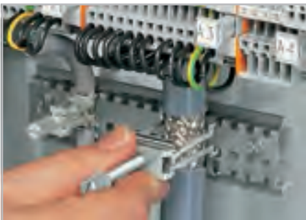
Установка дополнительного зажима для экрана.
