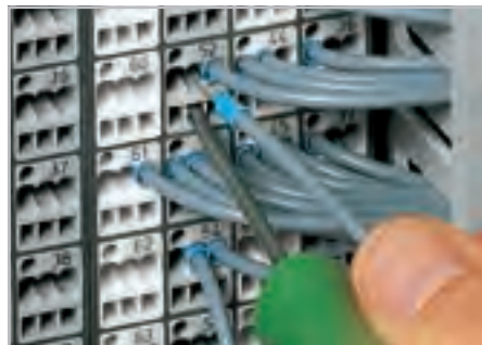
Подключение проводников с наконечниками.
