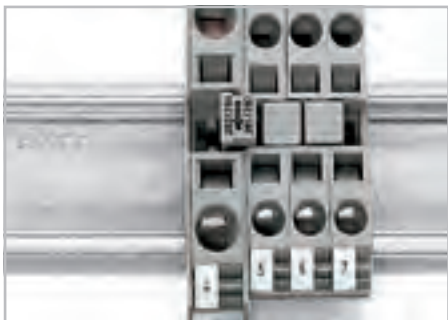
Примечание: перемычки, маркированы подходящими размерами клемм для правильной установки.
