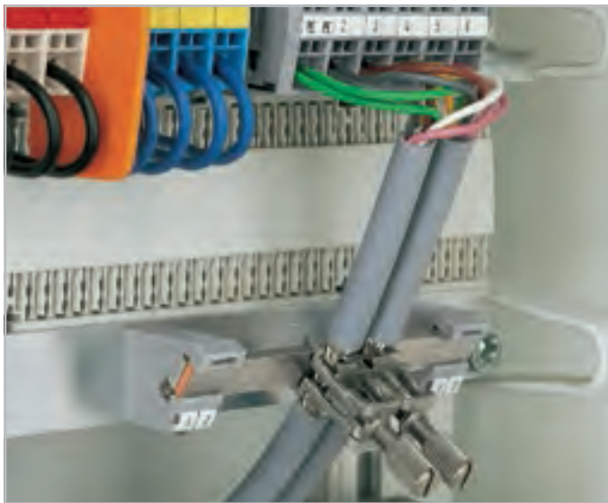
Изолированные фиксирующие держатели для общего опорного потенциала экрана, независимо от потенциала корпуса.
