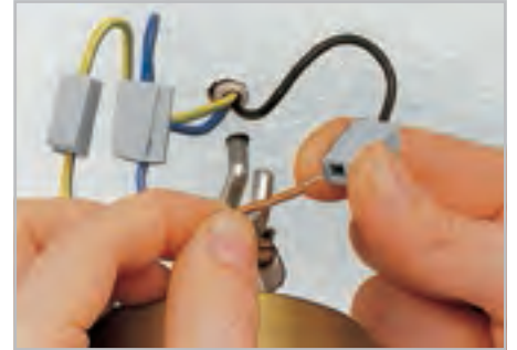
Отключение: нажать кнопку и извлечь проводник.
