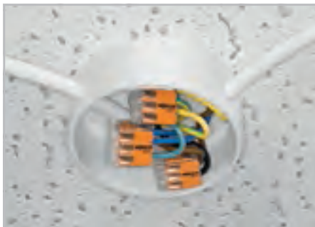
Распределение питания для потолочных светильников
