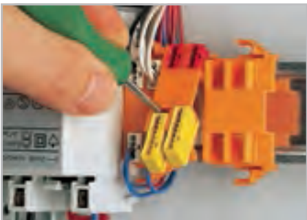
Извлечение клемм PUSH WIRE® из держателя.
