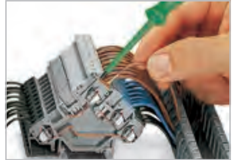
Присоединение проводника с помощью прямого рабочего инструмента (210-720).
