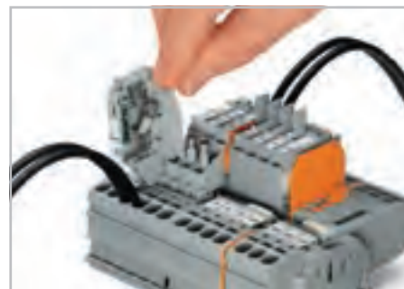
Открытие крышки для замены предохранителя.
