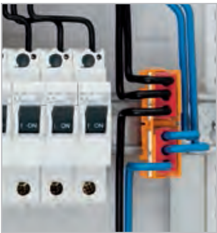
Подключение одножильных и многожильных проводников 6 мм 2 /AWG 10.
