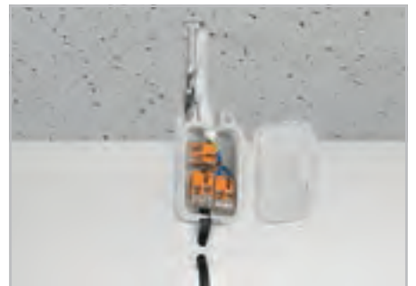
Подвесное присоединение светильников в подвесных потолках
