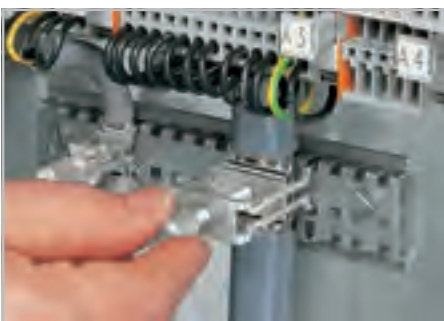
Затяжка/удаление зажима для экрана.
