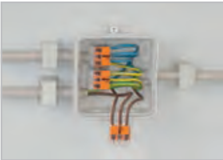
Электромонтаж тонких многожильных проводников в распределительной коробке.
