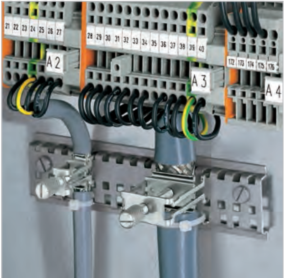
Монтаж распорной втулки на несущую рейку со специальной перфорацией.
