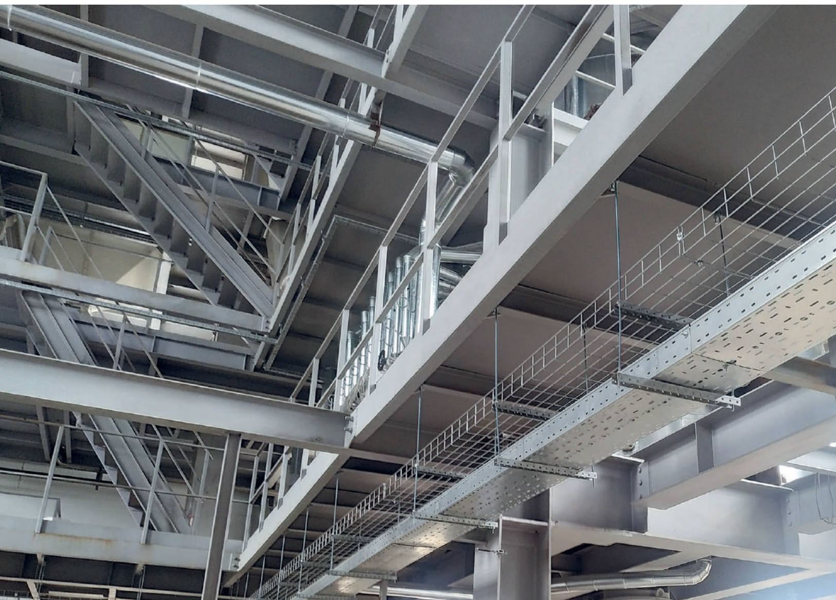
Наши объекты: Маслоэкстракционный завод, Воронежская область.
