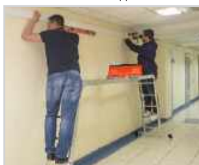
Возможность трансформироваться в помост позволяет производить точный монтаж крупногабаритных электроустановок и длинных направляющих для потолочных конструкций с двух сторон одновременно.
