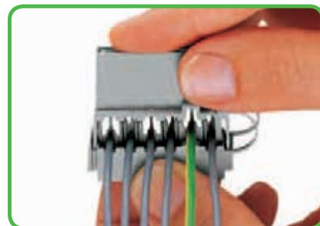
Установите верхнюю и нижнюю части розетки в состояние готовности к замыканию ...
