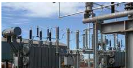
Австралия: трансформатор 132kV для ВНР
