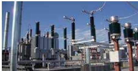
Япония: изолирующий трансформатор и силовой трансформатор для APR Energy
