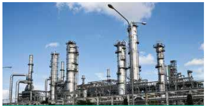
Ирак Salah - Электростанция Aldeen 2X630MW
