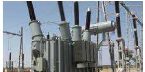
Буркина-Фасо: силовой трансформатор для Forclum
