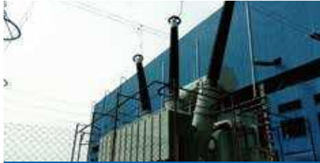
Индия: трансформатор 420kV 60MVA
