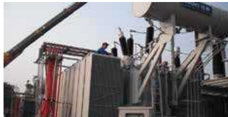
Бангладеш: силовой трансформатор для Aggreko
