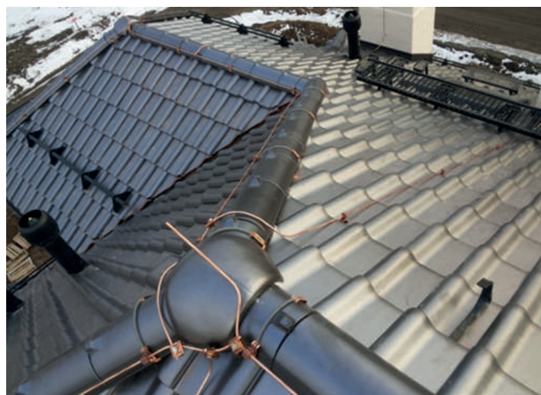
Молниеприемная сетка на скатной кровле
