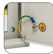
Обмедненные шпильки. Закрепленный поводок заземления
