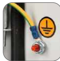
Обмедненные шпильки. Закрепленный поводок заземления
