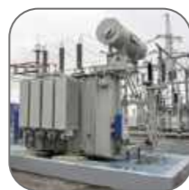
Объекты энергетической отрасли
