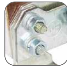
Болты с повышенным классом прочности
