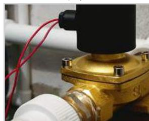
Дистанционное управление электрооборудованием (например, перекрытие воды при помощи электромагнитного клапана).
