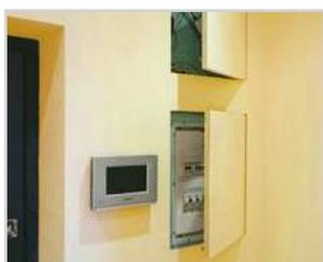
Для доступа к инженерным коммуникациям и элементам управления сантехническими и электрическими системами.
