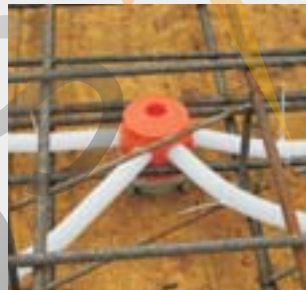
Пример установки в горизонтальной опалубке.
