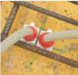
Пример использования концевых втулок и муфт.
