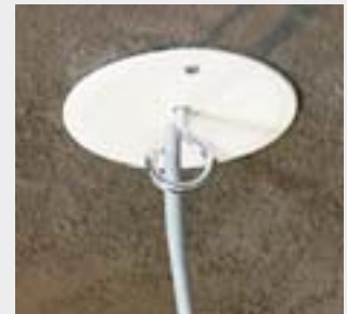
Коробка КВТ... закрытая крышкой V 68 S с выведенным проводом и люстровым крюком KBP...
