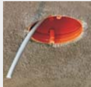
Коробка КВТ... с выведенным проводом, готова для установки люстрового крюка KBP...
