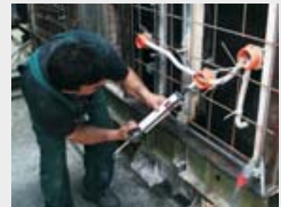
Герметизация вводов (отверстий).
