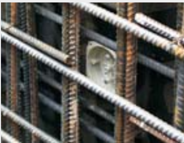
Крышка KBV, прикрепленная на опалубке.
