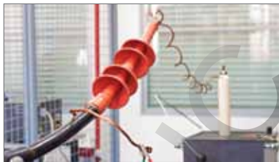
Высоковольтные испытания кабельных муфт
