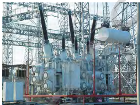
Электрические сети Электростанции, подстанции, линии электропередач
