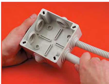
Заводим гофрированную и жесткую трубы
