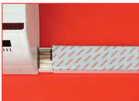
Закройте смонтированную трассу крышкой
