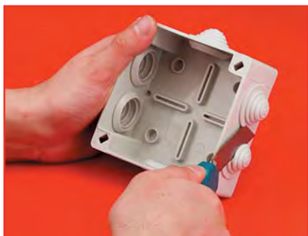
Срезаем кабельный ввод
