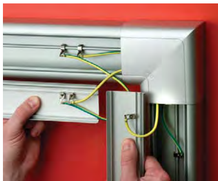
Количество монтируемых проводов заземления в плоском угле
