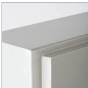
Полностью проваренные швы.
