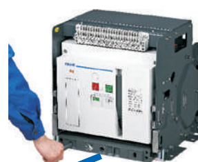
Рис. 4. Извлечение ручки
