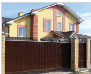
Ворота с автоматическими приводами.
